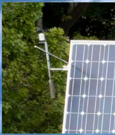
Windmesser (ab 7Bft dreht die Anlage auf Tischposition)
