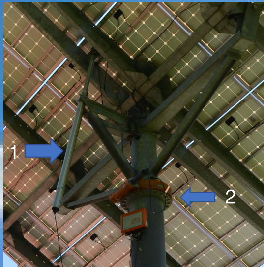
1 Elevationsantrieb 2 Azimuthantrieb
