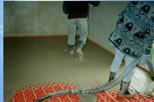
Fußbodenheizung mit Anhydritestrich
