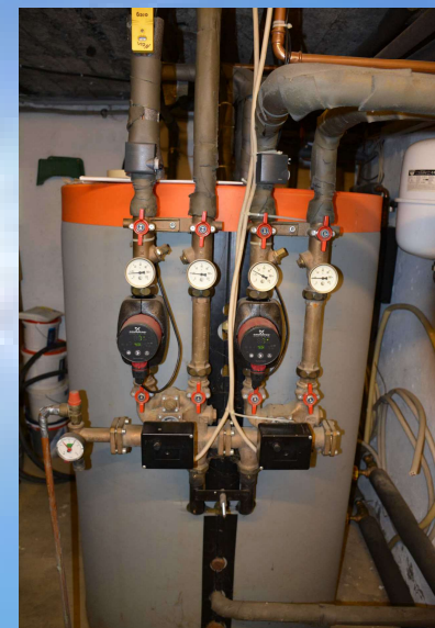
Der alte Pufferspeicher mit neuen Pumpen mit und ohne Verkeidung
