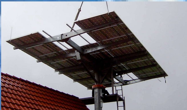
Aufbau mit Kran
