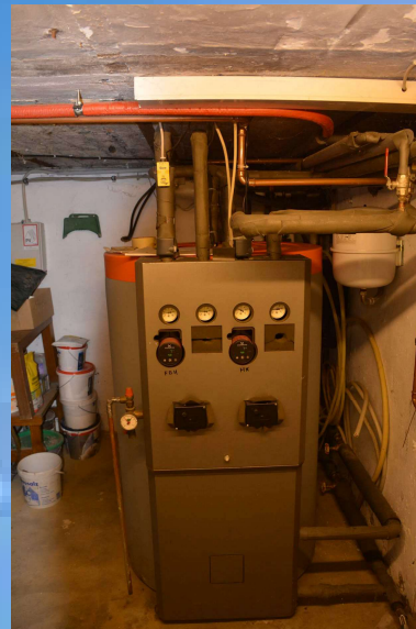
Der alte Pufferspeicher mit neuen Pumpen mit und ohne Verkeidung
